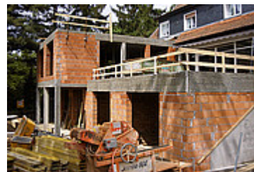
Terrasse im Rohbau
