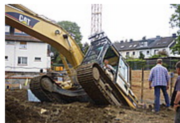
Bagger kommt aus der Grube
